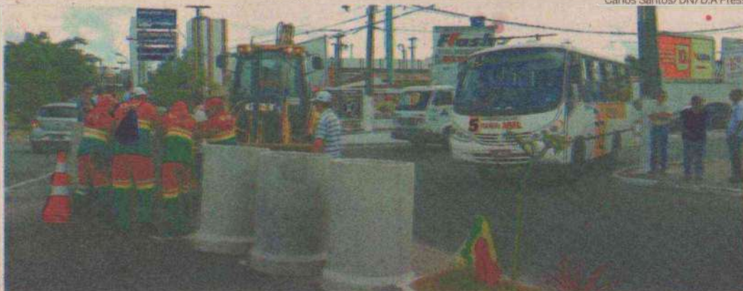
Fechamento do acesso para a Av. Maria Dolores, que passa a ter sentido único, causou engarrafamento e irritação
