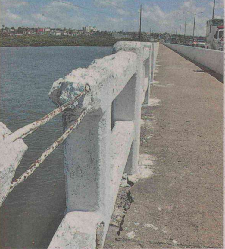
Ponte também apresenta problemas como o passeio de pedestre quebrado, asfalto da pista rachando e mureta de proteção quebrada ao longo de vários pontos
