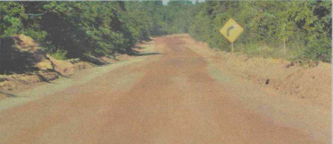
A espera do edital: obras de construção de acessos às BRs estão contratadas, mas não ainda foram iniciadas
