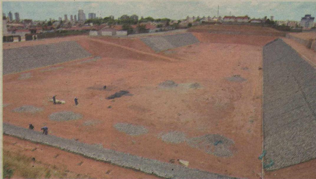
Obra contempla construção de lagoa de captação e a drenagem e pavimentação de quatro ruas no entorno do reservatório
