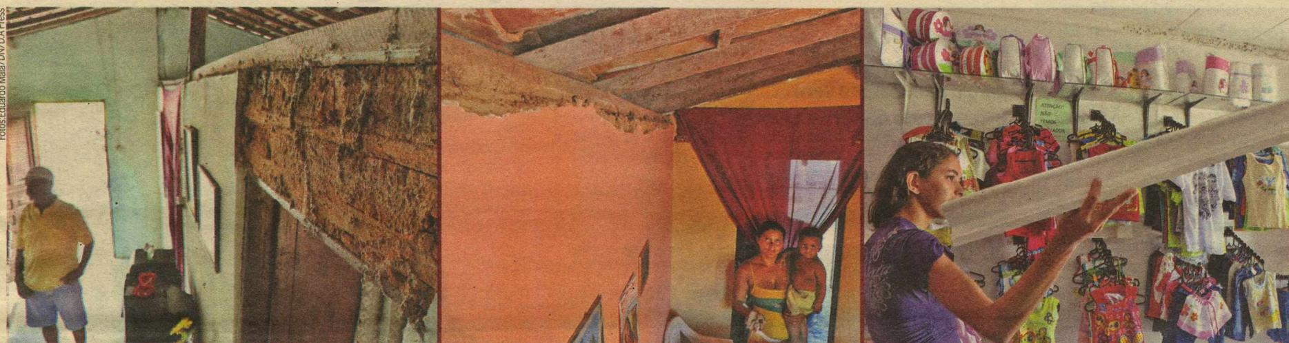
Força do terremoto fez reboco de cimento se soltar da parede, provocou rachaduras em residência, em Poço Branco, e derrubou uma placa de gesso, em Taipu. Defesa Civil entrou em alerta
